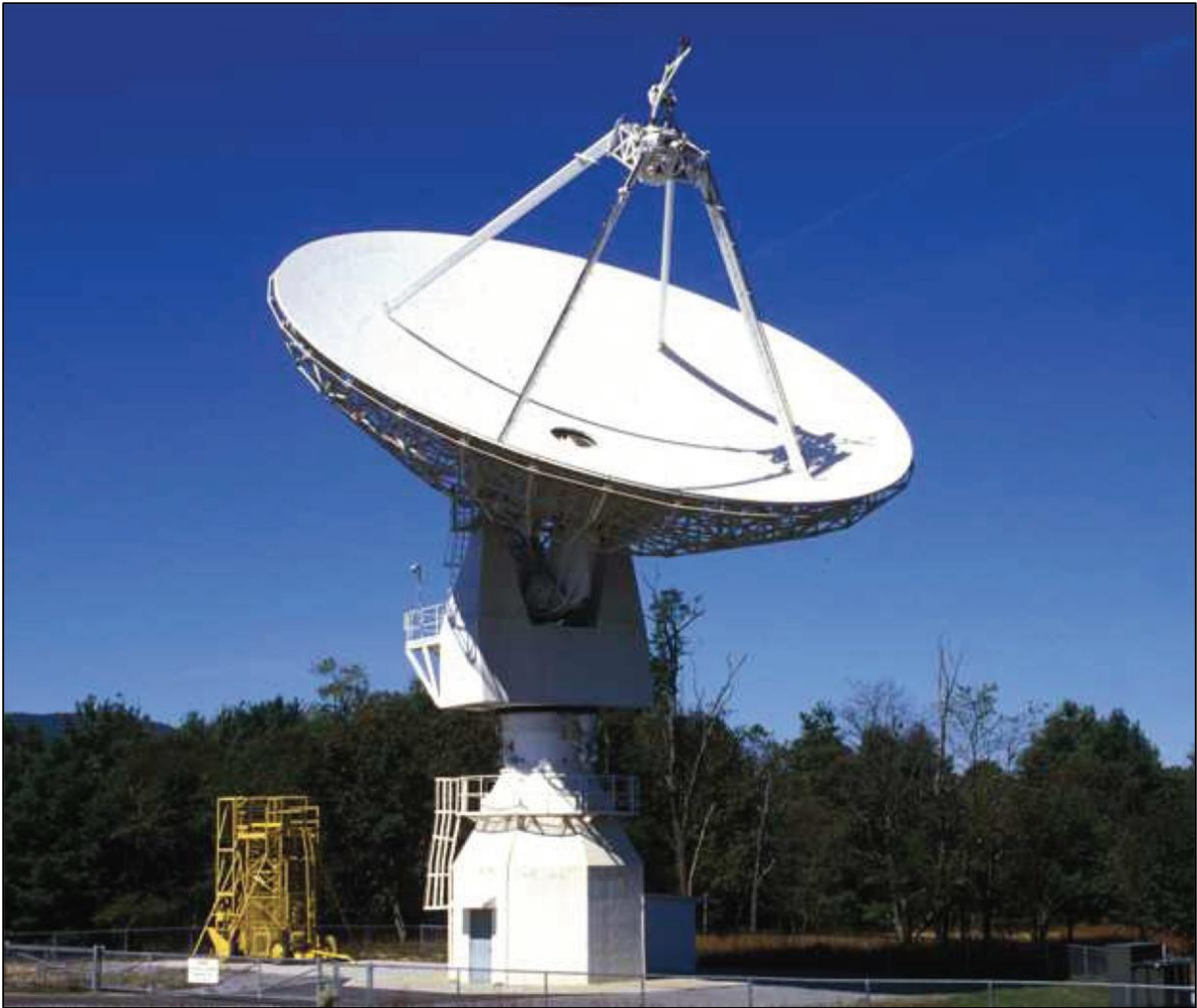
სურათი 2. კლასიკური კასეგრენისეული რადიო ტელესკოპი. ეროვნული რადიო ასტრონომიული ობსერვატორიის 20-მეტრიანი რადიო ტელესკოპი, რომელიც მდებარეობს გრინ ბანკში, დასავლეთ ვირჯინიის შტატში.
